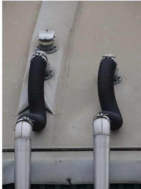
Figure 42: Gasometer blowers Source: Principi di Porcia e Brugnera
