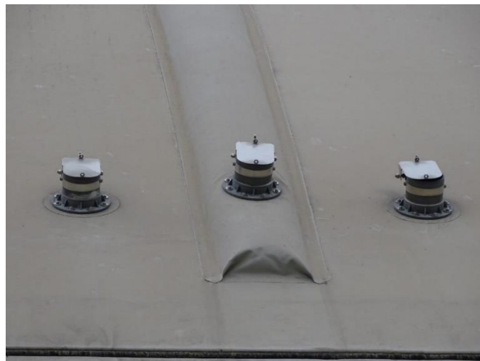
Figure 43: Relief clapet Source: Principi di Porcia e Brugnera
