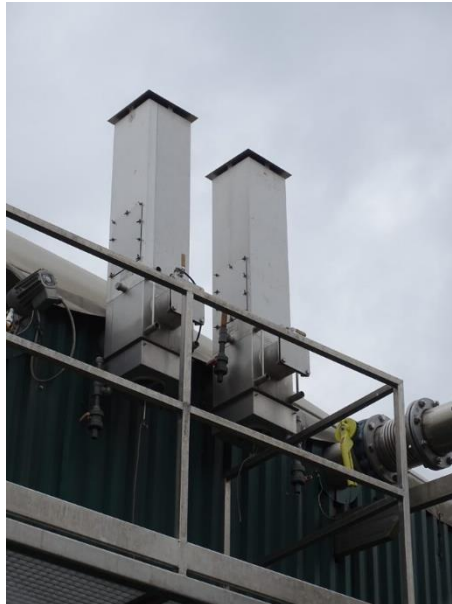
Figure 38: Hydraulic guards Source: Principi di Porcia e Brugnera
